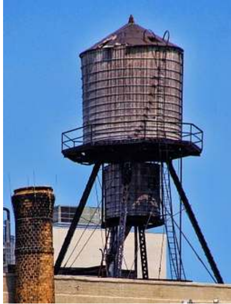
FIGURE 21 – Un water tanks de la ville de New York ( photo domaine public )
