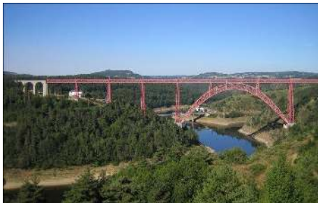
Viaduc de Garabit, Auvergne.
